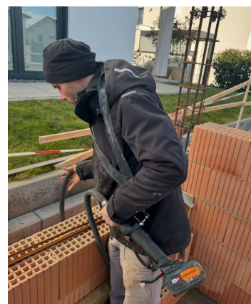
Spielend leicht Beton in Schalungssteinen verdichten
