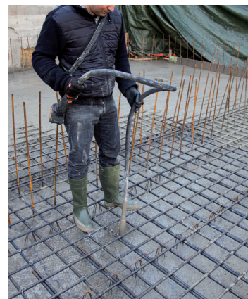
Effektives Verdichten von Betonfundamenten
